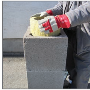
6.2 A szigetelő lapot meghajlítjuk és behelyezzük.
