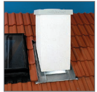
13.4 A kéményfejet függőlegesen felhelyezzük. Az oldalsó csavarokat a köpenytégláig meghúzzuk. A torkolati kúpot felhelyezzük (ld.: 11.1-11.10 ábrák)
