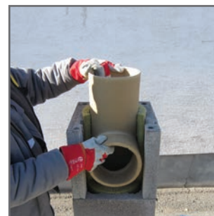
9.4 Behelyezzük a csatlakozót
