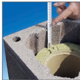
14.1-14.2 Az utolsó samottcsövet és a szigetelő lapot úgy vágjuk el, hogy 10 cm hőtágulási hézagot biztosítsunk.
