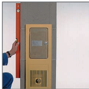
7.2 A kéménytalpat függőlegesen a habarcsba állítjuk.
