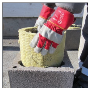
9.6 Meghajlítjuk a szigetelő lapokat, és már előre behelyezzük a következő köpenytégglába.
