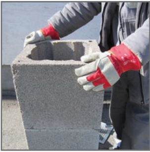
6.1 A köpenytéglát a habarcs-terítésbe helyezzük
