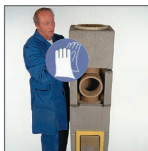
9.7 Az így előre előkészített köpenytégglát felhelyezzük.
