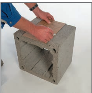
8.1 A köpenytéglára a kivágó sablon segítségével felrajzoljuk a tisztítóajtó nyílását.
