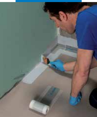
Mapeband PE 120 szalag elhelyezése Mapegum WPS-sel
