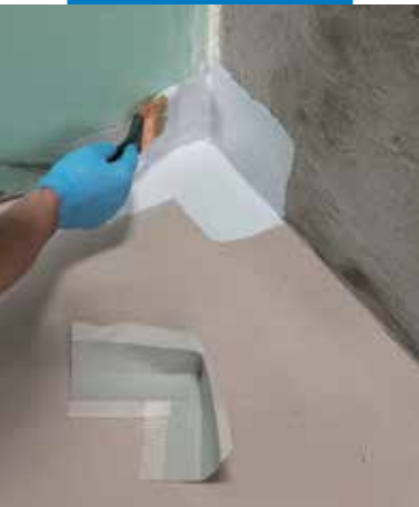
90°-os Mapeband PE 120 sarokelem elhelyezése Mapegum WPS-sel
