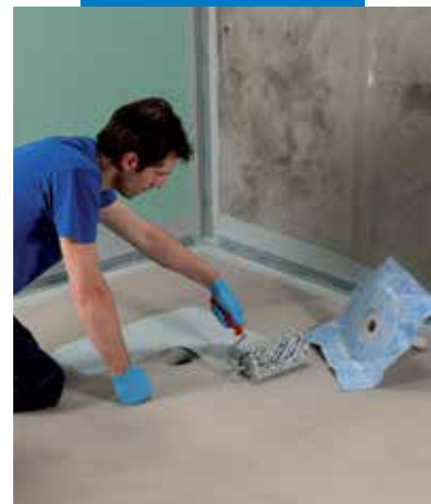
Drain Vertical csatlakoztatása Mapegum WPS-sel
