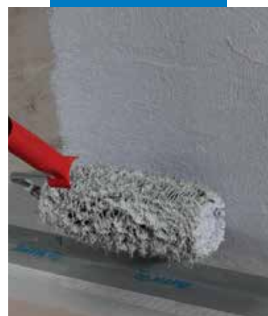
Mapegum WPS felhordása hengerrel
