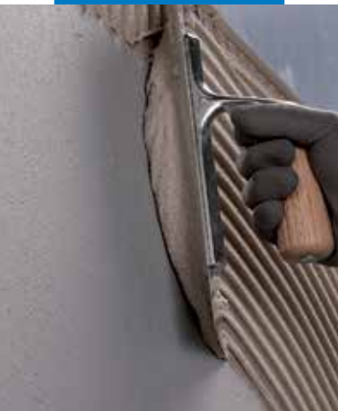
Padlóburkolat elhelyezése Ultramastic III használatával
